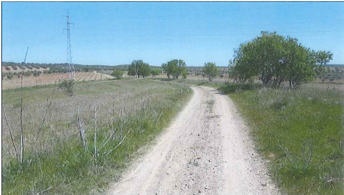
Figura 1. Zona en la que se construirá la subestación. Se observa el tendido actualmente existente al que evacuará la energía la central fotovoltaica.
